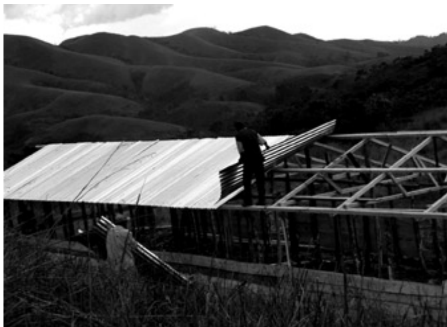
Le toit de l'école primaire de Murhume, Nindja, est recouvert de tôles.
