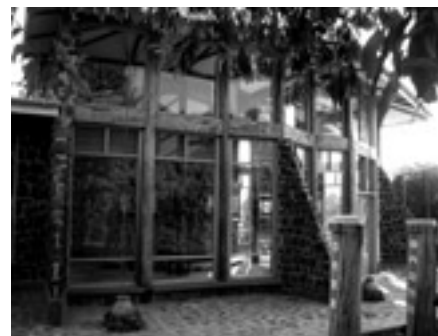
Le nouveau centre des visiteurs du Parc National des Gorilles de Mgahinga
